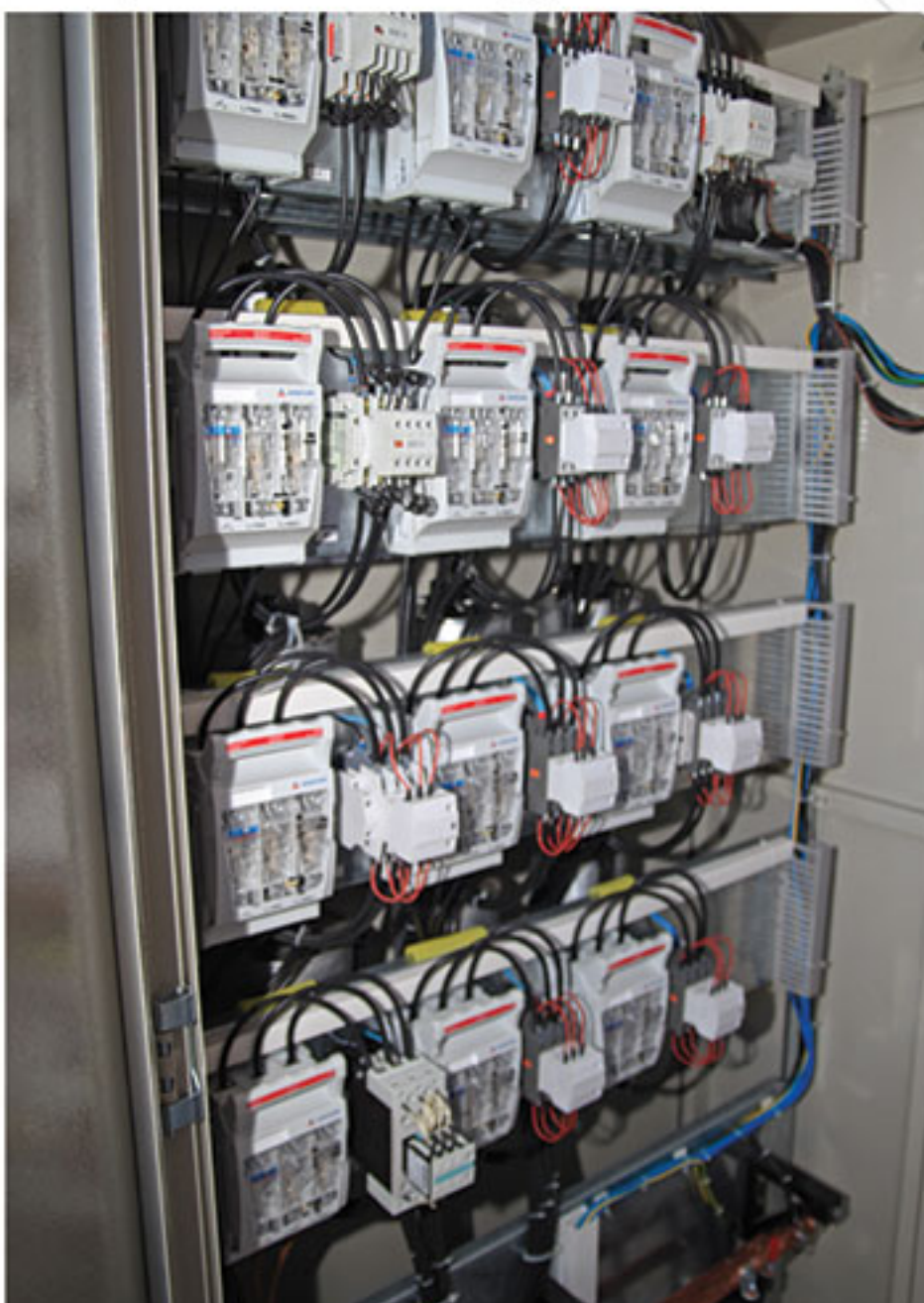
Komp.reaktivne energije 200kVAR
