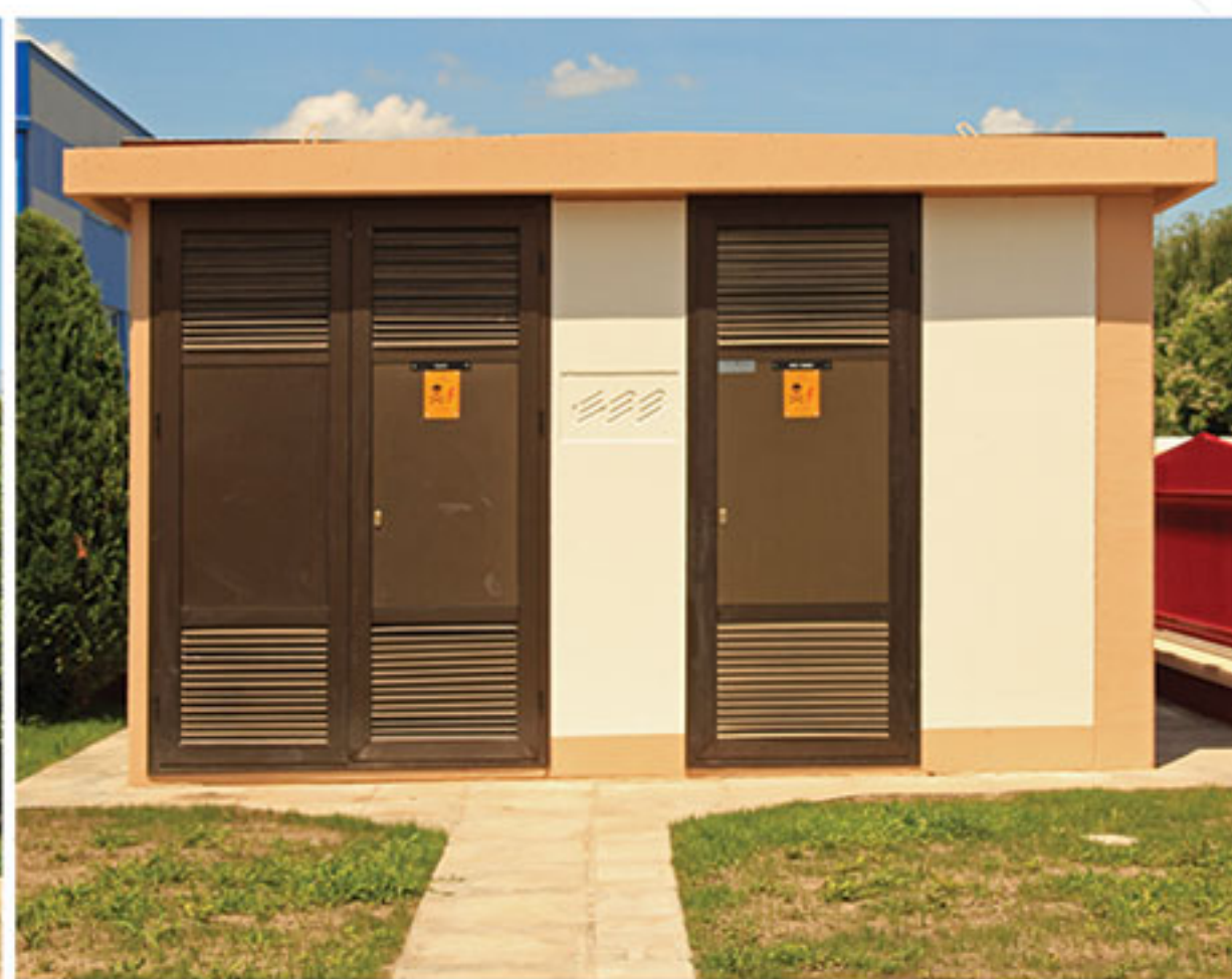
NN blok sa kompenzacijom 200kVAR
