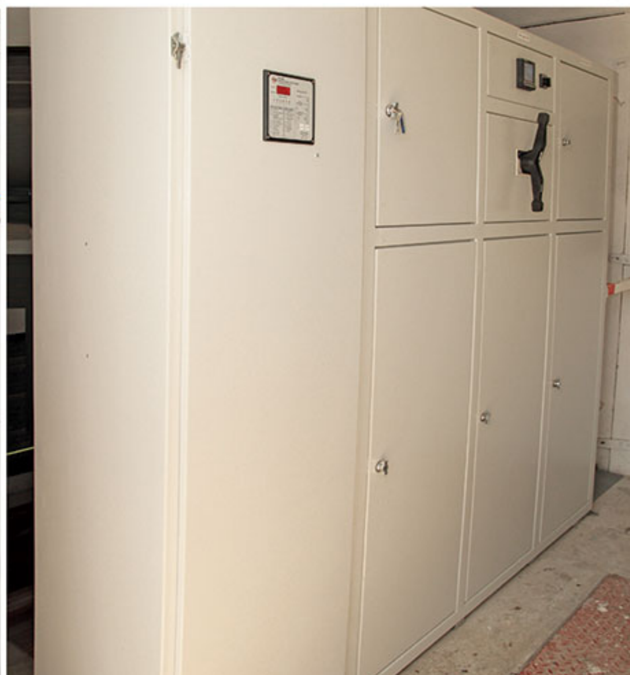
NN blok sa kompenzacijom 200kVAR
